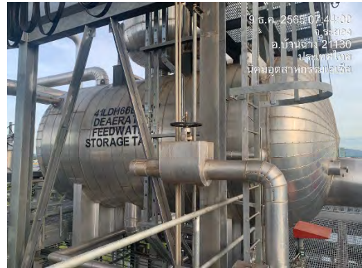
ภาพที่ 2.2-45 ฉนวนหุ้มเปลือกหม้อน้ำ
