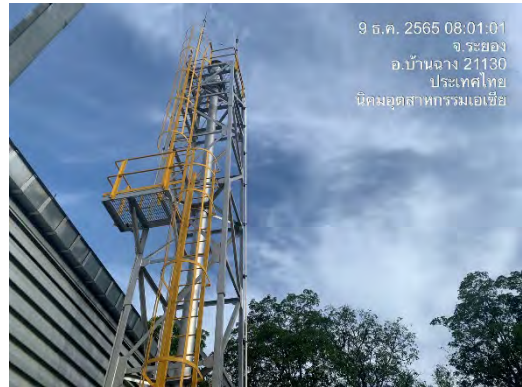
ภาพที่ 2.2-40 ท่อระบายก๊าซกรณีฉุกเฉิน
