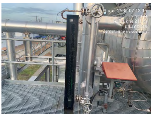
ภาพที่ 2.2-43 มาตรวัดระดับน้ำที่หม้อน้ำ
