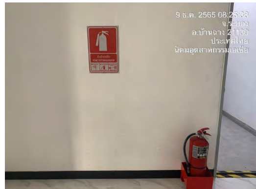
ภาพที่ 2.2-25 อุปกรณ์ดับเพลิง
