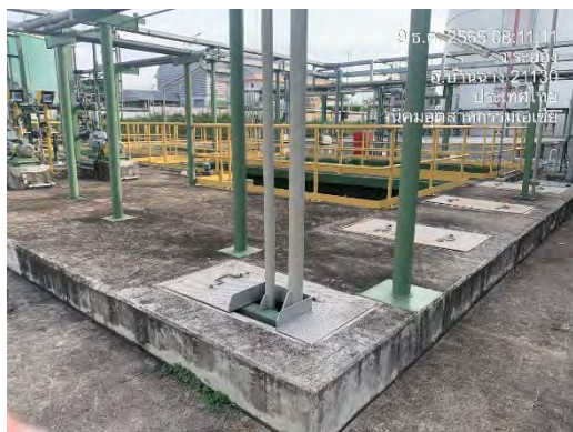
ภาพที่ 2.2-7 ถังแยกน้ำมัน (Oil-Water Separator)
