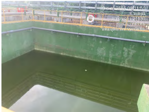
ภาพที่ 2.2-11 บ่อพักน้ำฉุกเฉินขนาด 320 ลูกบาศก์เมตร
