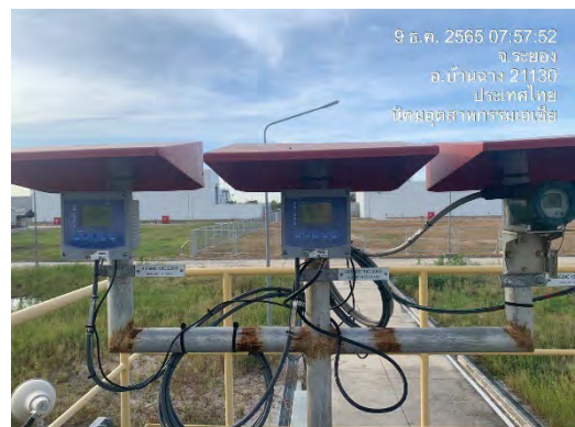
ภาพที่ 2.2-8 เครื่องตรวจวัดคุณภาพน้ำแบบอัตโนมัติ
