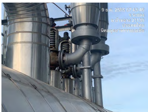
ภาพที่ 2.2-42 ลิ้นนิรภัย (Safety Valve) ที่ท่อ steam ของหม้อน้ำ
