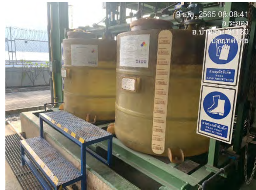
ภาพที่ 2.2-31 Dike ล้อมรอบถังเก็บสารเคมี
