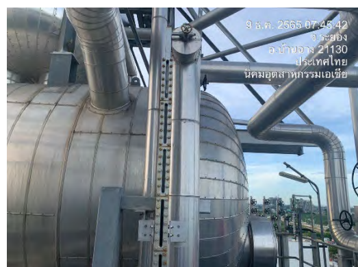
ภาพที่ 2.2-43 มาตรวัดระดับน้ำที่หม้อน้ำ
