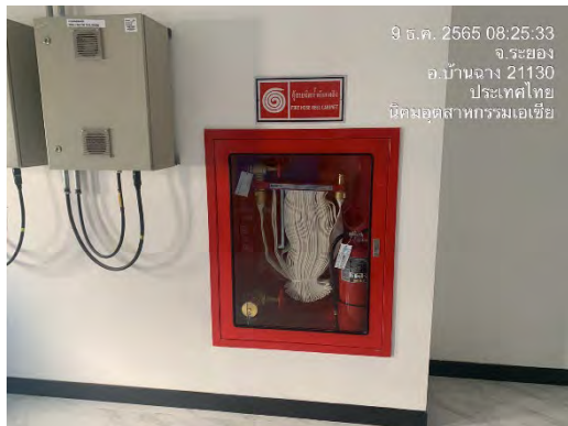
ภาพที่ 2.2-25 อุปกรณ์ดับเพลิง
