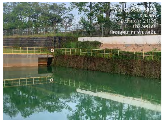
ภาพที่ 2.2-22 บ่อหน่วงน้ำ ขนาด 2,880 ลูกบาศก์เมตร
