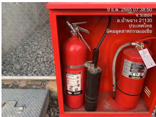
ภาพที่ 2.2-41 ถังดับเพลิงชนิดผงเคมีแห้ง
