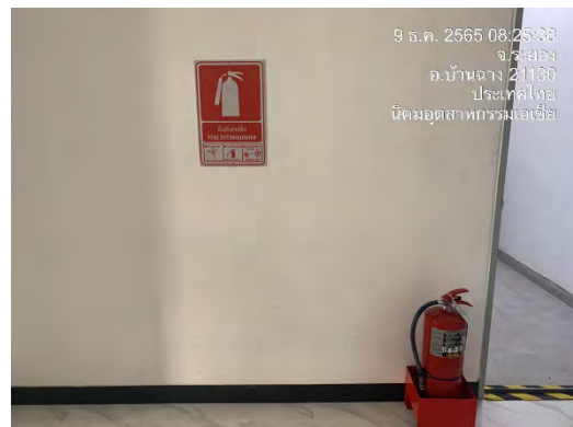
ภาพที่ 2.2-41 ถังดับเพลิงชนิดผงเคมีแห้ง
