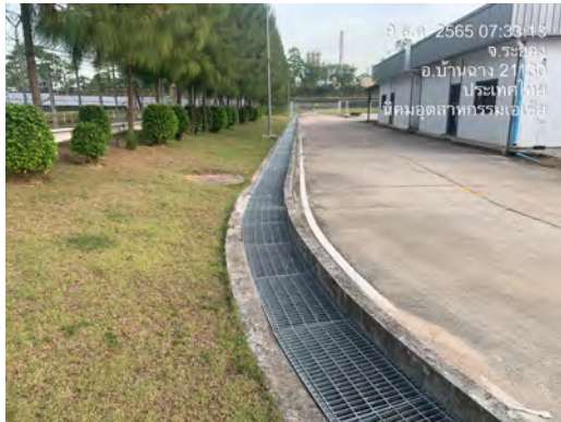
ภาพที่ 2.2-21 รางระบายน้ำฝนของโครงการ
