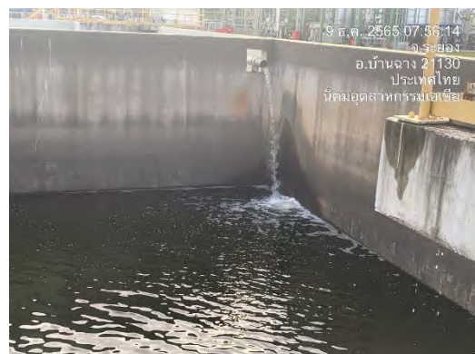
ภาพที่ 2.2-10 บ่อพักน้ำทิ้ง ขนาด 1,800 ลูกบาศก์เมตร
